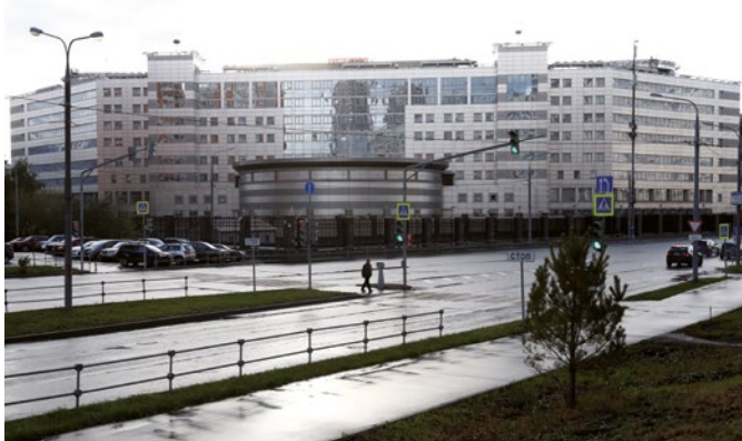
Gebäude des GRU
